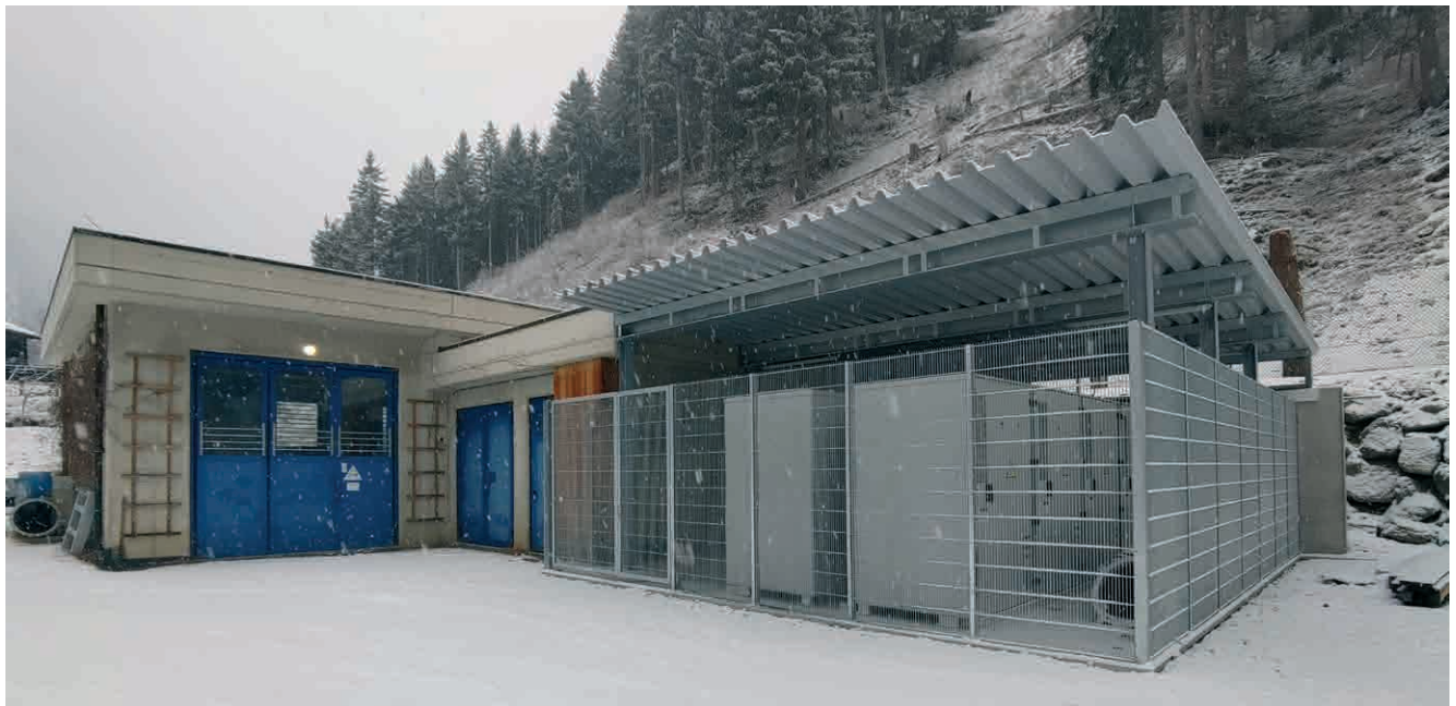
Krafthaus mit Batteriespeicher
